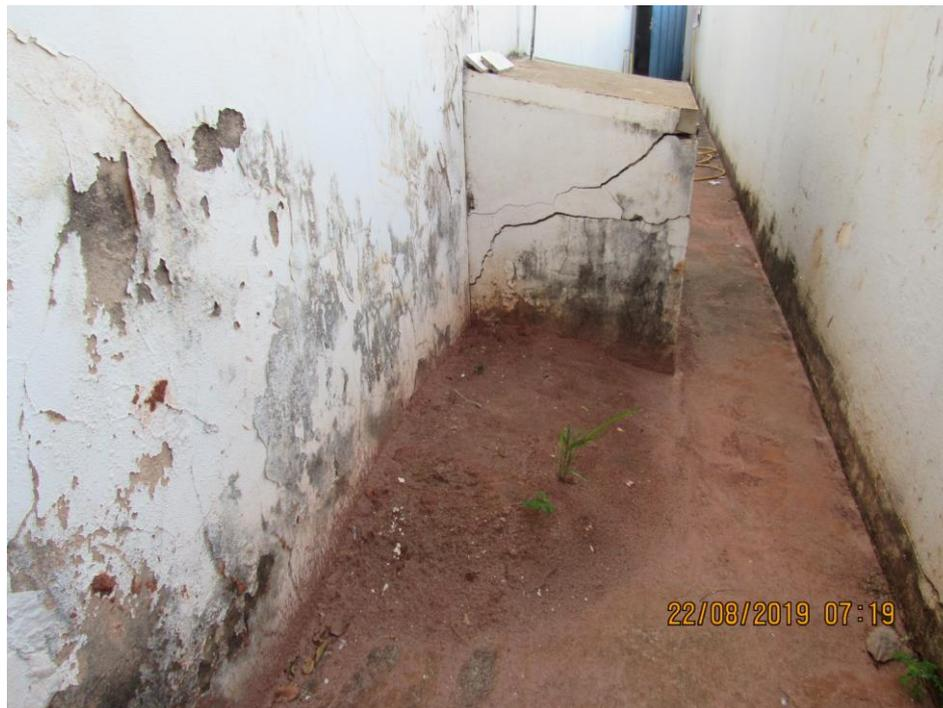
Foto 05- Parte externa da edificação necessitando de reforma, Pintura, identificando as marcas do reforço estrutural;
