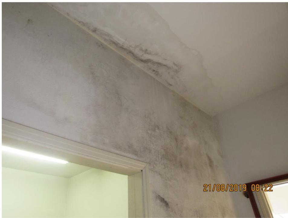
Foto 02- Várias salas com infiltração;
