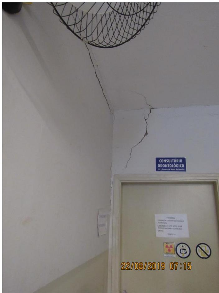
Foto 03- Todas as rachaduras na parede da edificação, necessitam de reparo e pintura, pois o reforço estrutural já foi executado;
