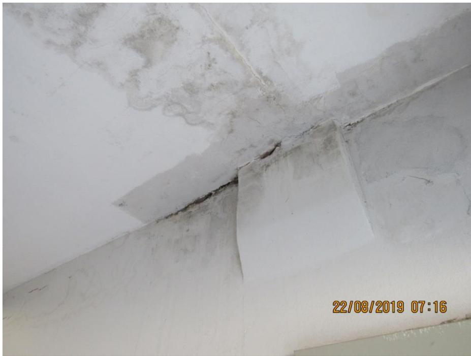
Foto 04- Várias salas com infiltração, aguardando a troca total da cobertura da edificação;
