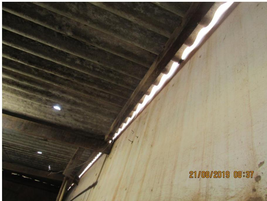
Foto 07- Calhas e rufos serão instalados e as telhas quebradas substituídas
