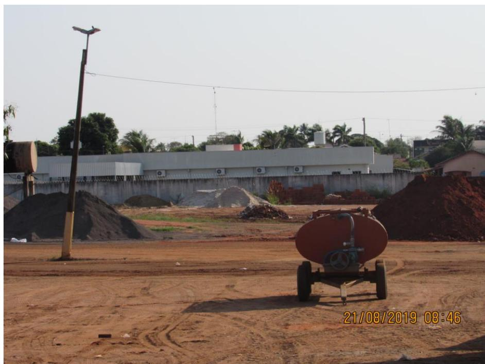
Foto 08- Os materiais serão separados com uma parede de alvenaria e o pátio compactado com solo brita para evitar poeira.
