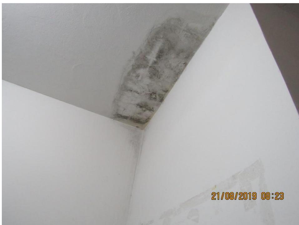
Foto 02- Várias salas com infiltração;
