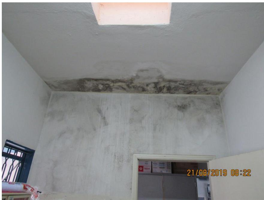
Foto 01- Necessita de reforma geral na cobertura/telhado da Edificação;
