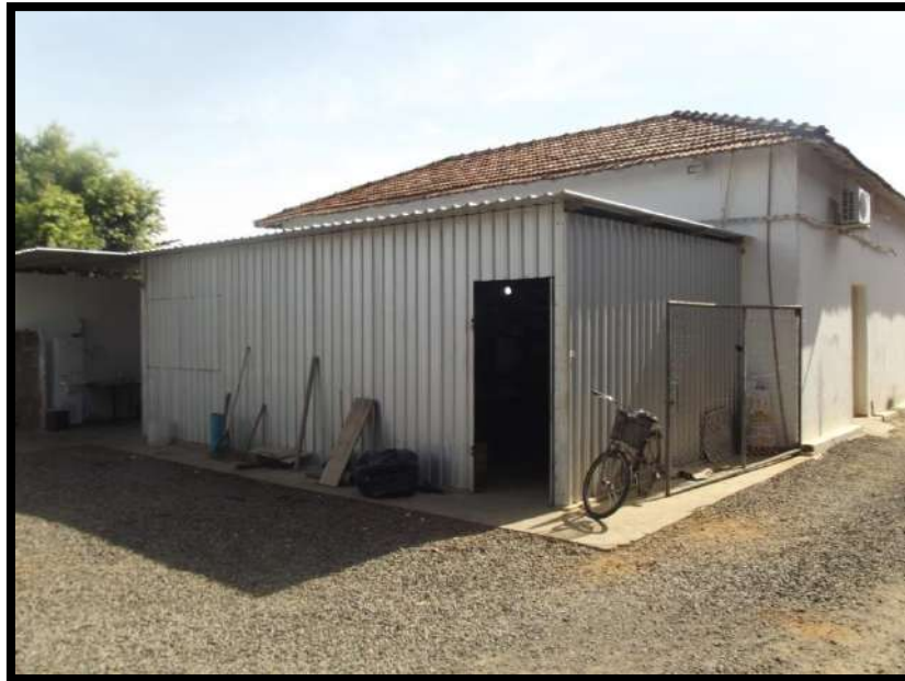
Barracão de armazenamento temporário resíduos eletrônicos
