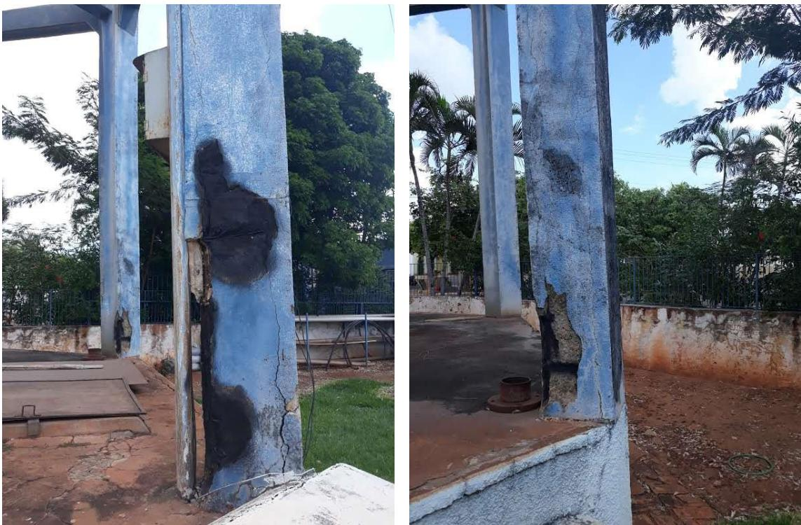
Constatamos condições precárias da estrutura do reservatório central de água, conforme fotos acima observa-se a existência de braçadeiras para reforço da estrutura e rachaduras nos pilares de sustentação.
