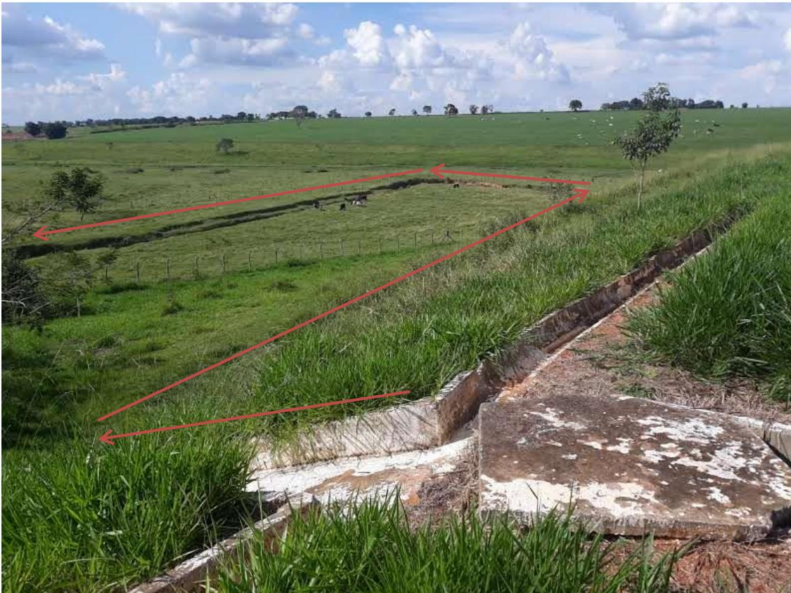
O Município possui 2 (duas) lagoas de tratamento de esgoto e, conforme percurso da água ilustrado na imagem acima, verifica-se que, na área de vazão do esgoto tratado, existem animais de corte que fazem ingestão da água saída da lagoa, a qual não se encontra dentro dos parâmetros ideais, segundo resultado da análise do esgoto tratado (documento 30), tendo em vista que o nível de D.B.O. apresentado na amostra foi de 129 mg/L, ao passo que o Valor Máximo Permitido era de 60 mg/L.
