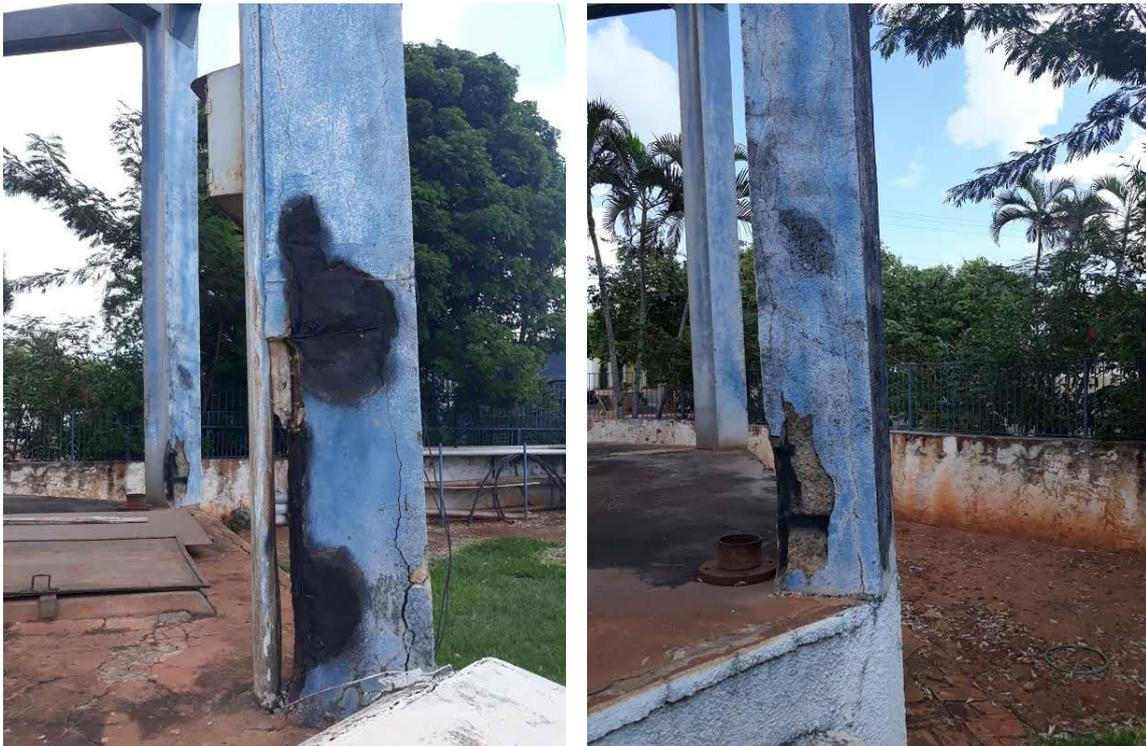
Constatamos condições precárias da estrutura do reservatório central de água, conforme fotos acima observa-se a existência de braçadeiras para reforço da estrutura e rachaduras nos pilares de sustentação.
